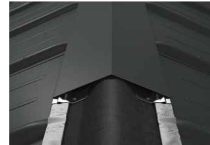
Obrázok 73 • Vytvorenie hrebeňa pomocou jednoduchého hrebenáča na hrebeň
