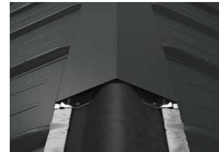
Obrázok 73 • Vytvorenie hrebeňa pomocou jednoduchého hrebenáča na hrebeň
