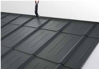
Obrázok 71 • Jednoduché vytvorenie hrebeňa pomocou závesného falcu
